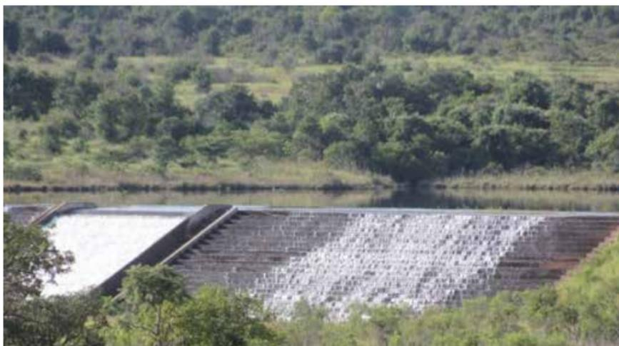
Figura 10. Barragem de derivação (desvio do curso das águas) do córrego Guariroba
